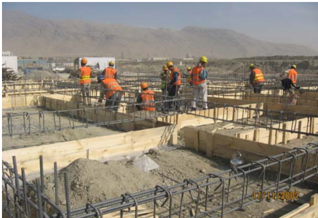
سیخ بندی grid beams
