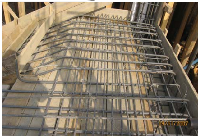
سیخ های منفی landing زینه که به زاویه 90 با بیم اتکا چنگک شده
