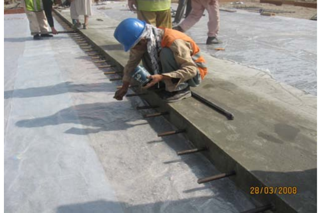
چرب کردن doweled bars برای جوینت انبساط در سلب K-Span جوینت انبساط یا Expansion joint در سلب K-Span
