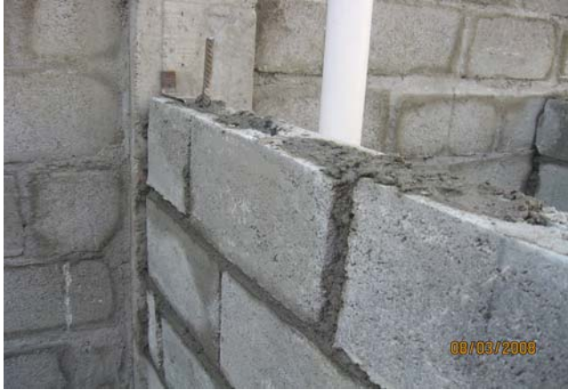
Flat strap برای اتصال بلوک کانکریتی با ستون
