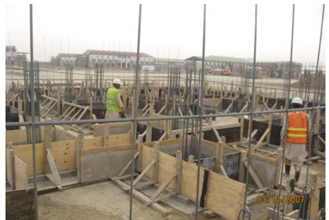
امتداد سیخ های neck column بخاطر splice های ستون های منزل اول. انجنیر نجیب الله در حال بررسی طول splice ستون ها
