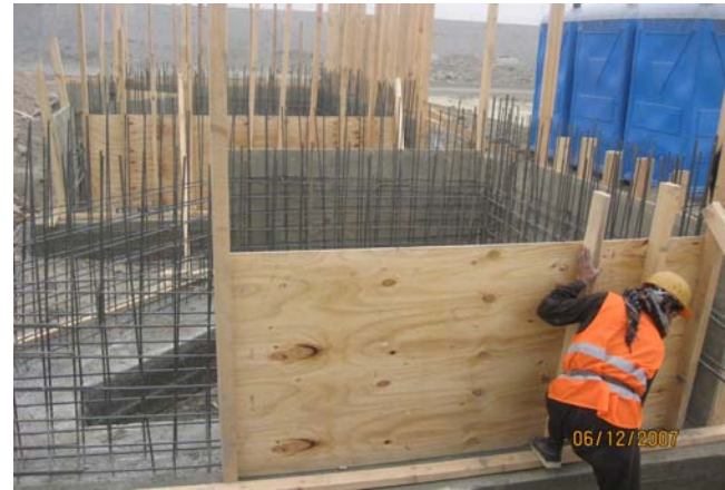
قالب کاری دیوار های باربری
