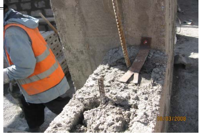
Flat strap برای اتصال بلوک کانکریتی با ستون
