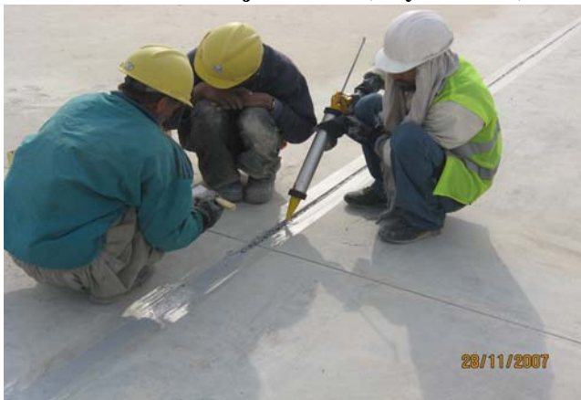
درز گیری جوینت انقباض بوسیله عامل درزگیری سلیکان
