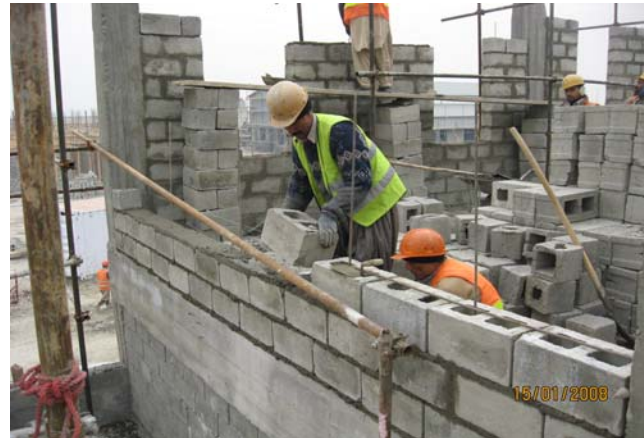
سیخ های افقی دیوار بلوک کانکریتی
