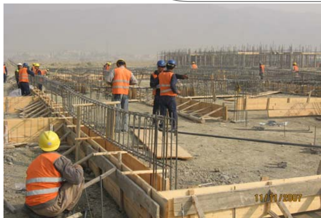
سیخ های منفی grid beam که به زاویه 90 در انجام آن چنگک شده
