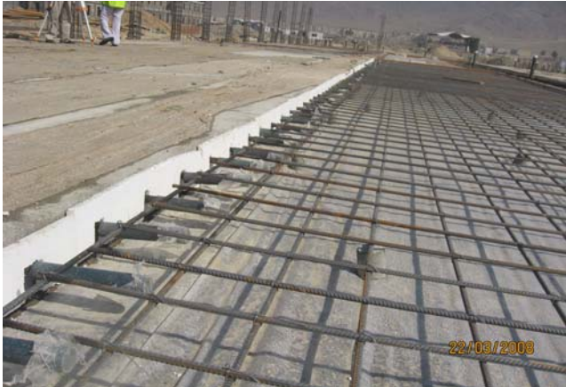
چرب کردن doweled bars برای جوینت انبساط در سلب K-Span جوینت انبساط یا Expansion joint در سلب K-Span
