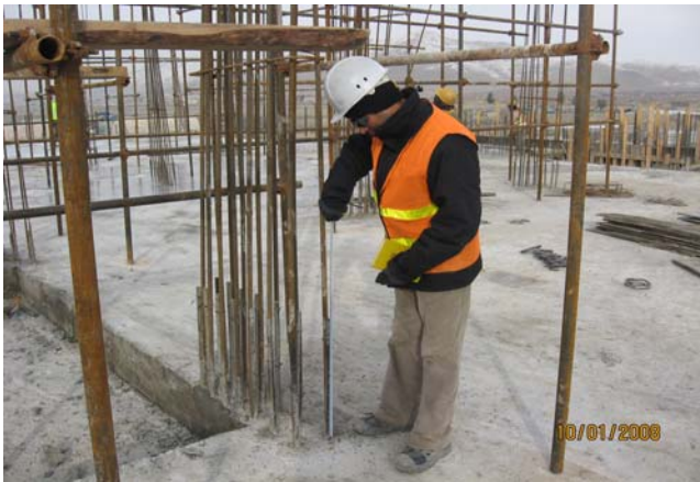
امتداد سیخ های neck column بخاطر splice های ستون های منزل اول. انجنیر نجیب الله در حال بررسی طول splice ستون ها
