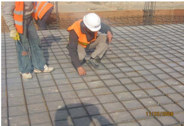
انجیر نجیب الله در حال بررسی splice سیخ بندی سلب K-Span
