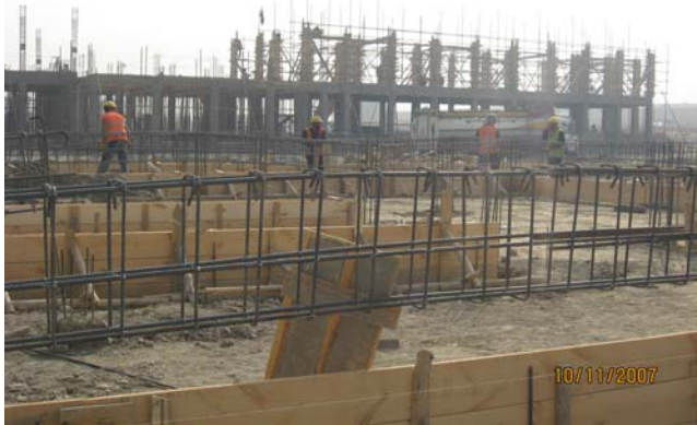
سیخ بندی grid beam که فاصله بین دو layer سیخ ها مراعات شده است
