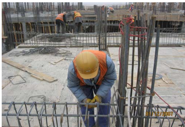
گزدمک های که به زاویه 90 درجه برای بیم های منزل اول استفاده شده
