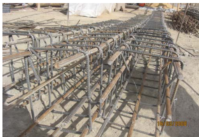
گزدمک های که به زاویه 135 درجه استفاده شده
