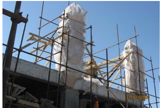
پوشش حرارتی ستون ها در مقابل هوای سرد
