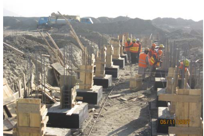
قالب کاری neck columns ها
