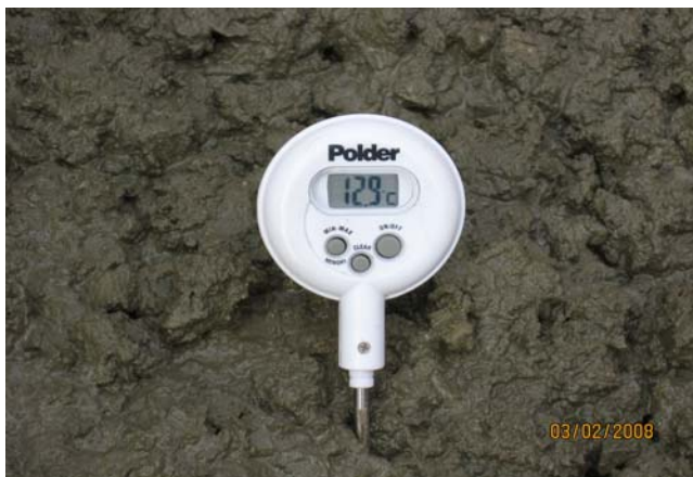
تست درجه حرارت کانکریت قبل از ریخت
