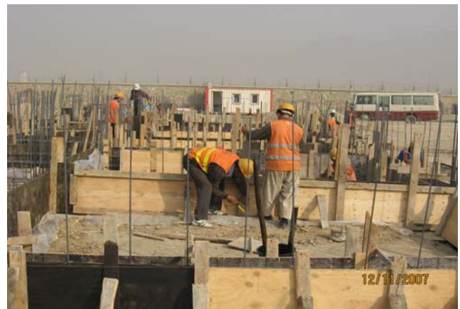
قالب کاری grid beams
