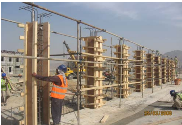
قالب کاری ستون های ساختمان K-Span
