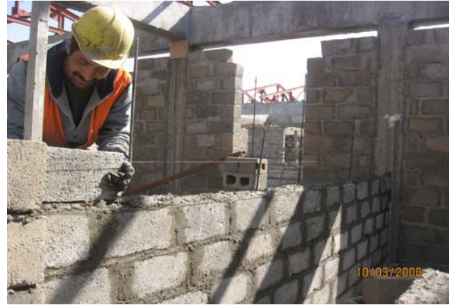
سیخ های عمودی دیوار بلوک کانکریتی
