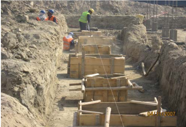
قالب کاری footings ها
