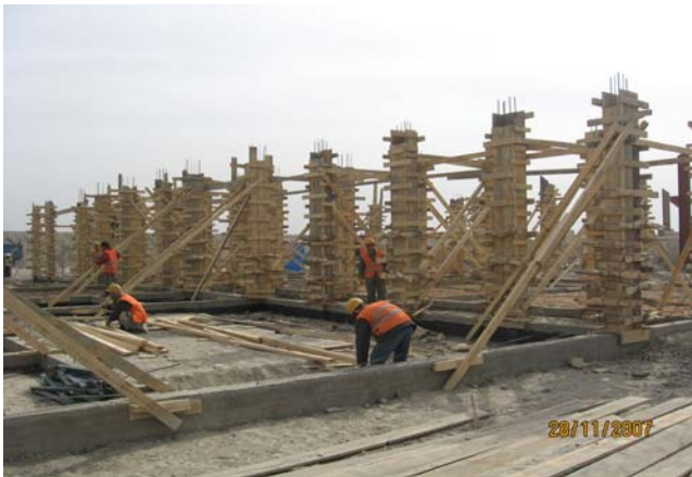
قالب کاری ستون های منزل اول
