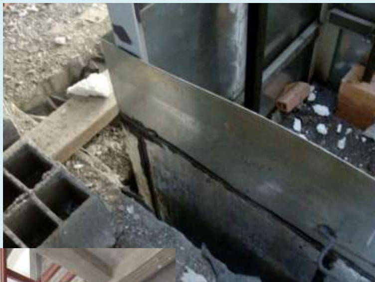
عایق بندی چاله آسانسور به کمک ورق آهنی
