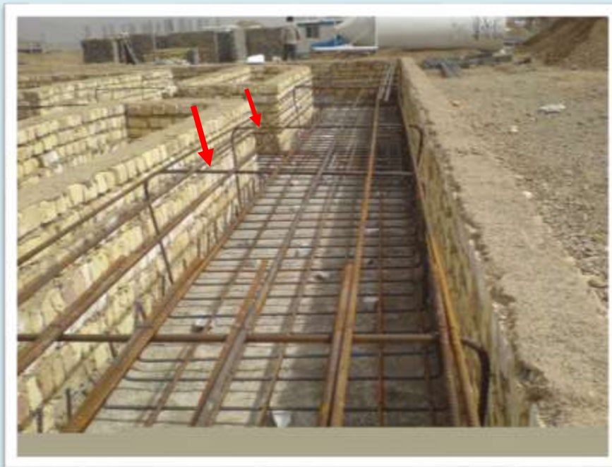
بستن خرک به صورت مورب در فنداسیون
