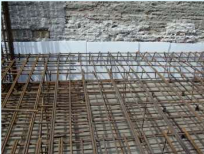
۹- یونولیت جداکننده پی همسایه اما در پروژه های بزرگ از دیوار حائل استفاده میکنند (توضیح دیوار حائل در پیوست الف)
