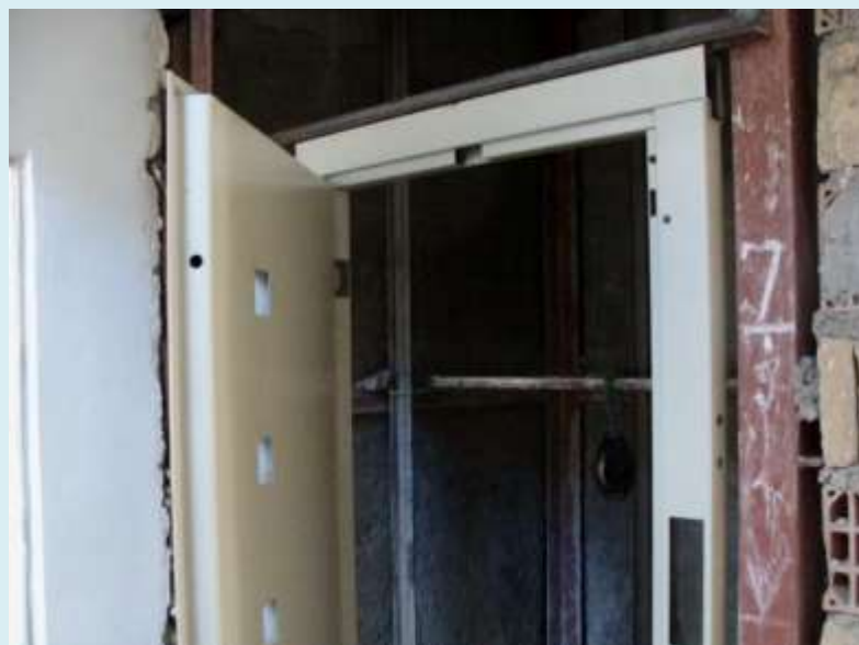
نصب درب آسانسور
