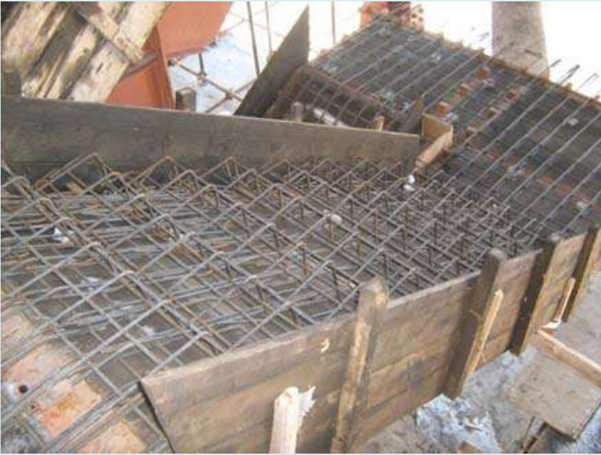
آرماتور بندی پله به صورت کامل بدون گذاشتن آجر
