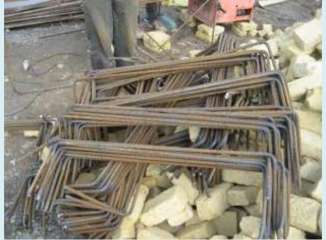
۶- میلگرد های برش داده شده برای دیوار برشی
