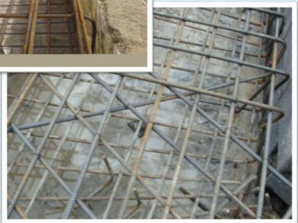
بستن خرک به صورت مورب در فنداسیون
