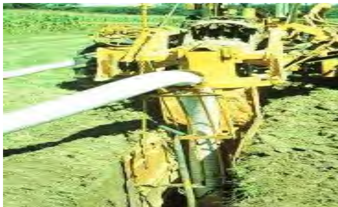
۲۵- شکل: نیمه سطحی ذهکشی سیستم لپاره د بلتیو او د پایونو ترتیبول
