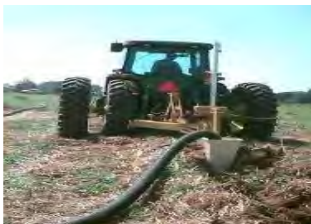
۲۶- شکل: سطحی ذهکشی سیستم لپاره د ویالو کیندل
