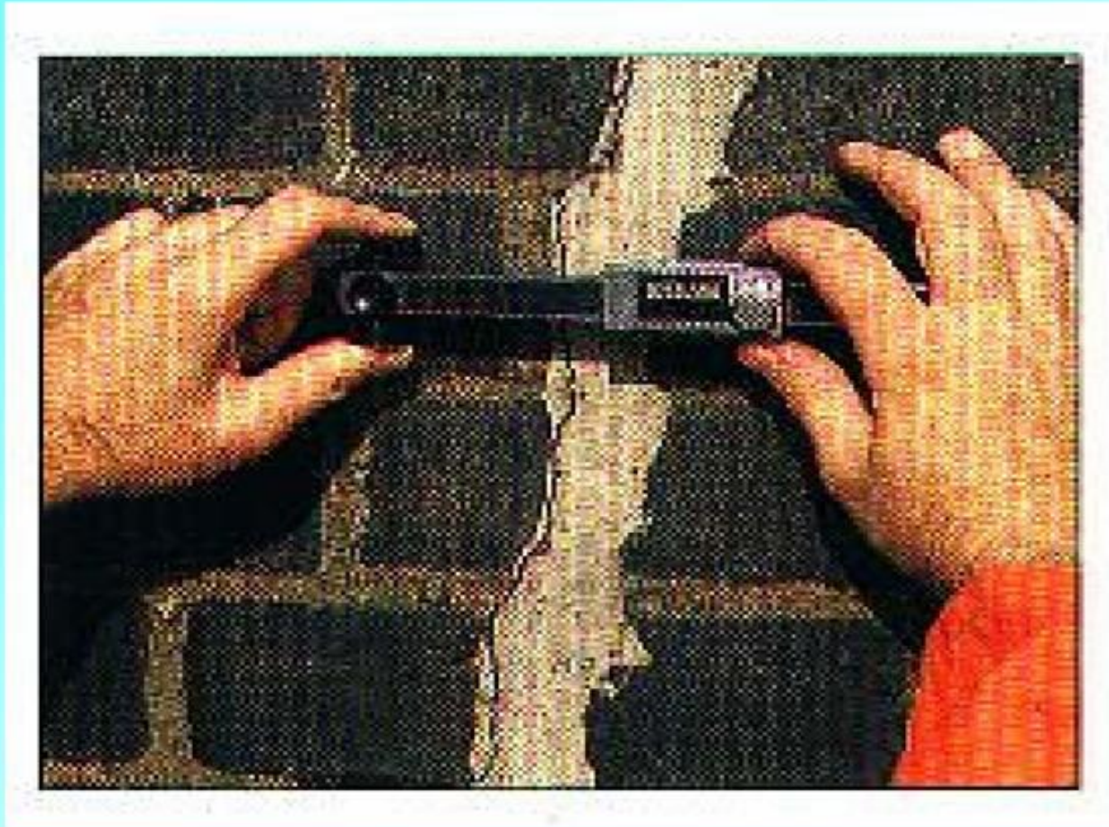
DIGITAL CRACK GAUGE - ELE
